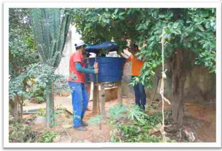
Para tanto, são colocados em suspensão caixas d'água que ficam interligadas por canos e/ou mangueiras estendidas até o sistema radicular das frutíferas.
